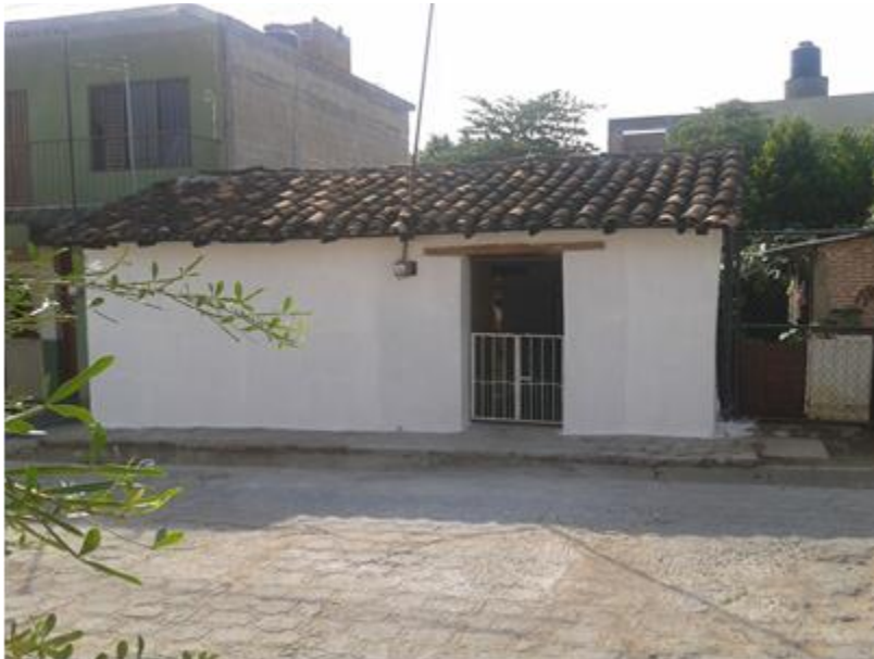
Figura 11. Vivienda tradicional V2 rehabilitada
