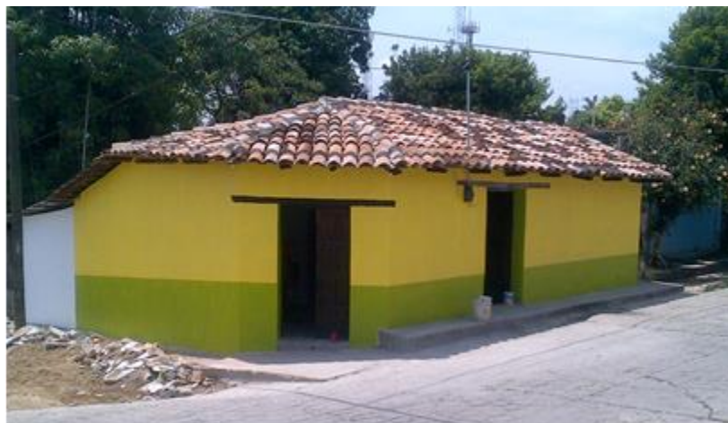
Figura 8. Vivienda tradicional V1 rehabilitada
