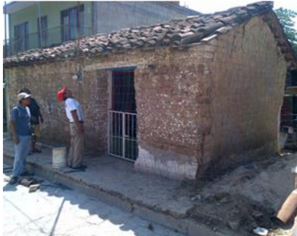
Figura 9. Fijación del refuerzo en vivienda V2
