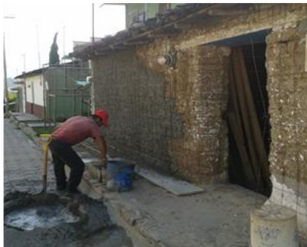
Figura 10. Aplicación de la capa de mortero
