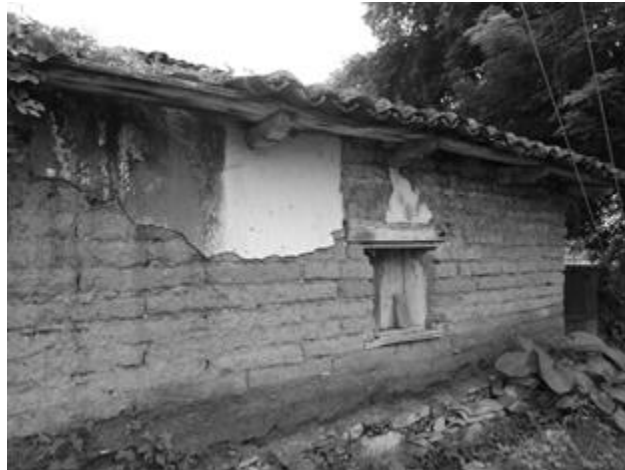
Figura 2. Vivienda tradicional con muros de adobe en Chiapa de Corzo, Chiapas
