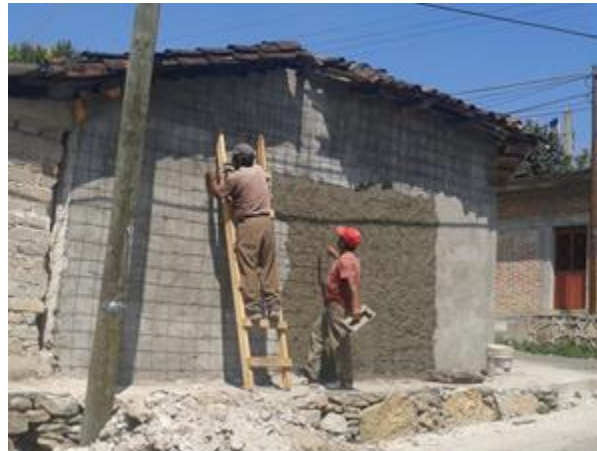
Figura 7. Aplicación de las capas de mortero
